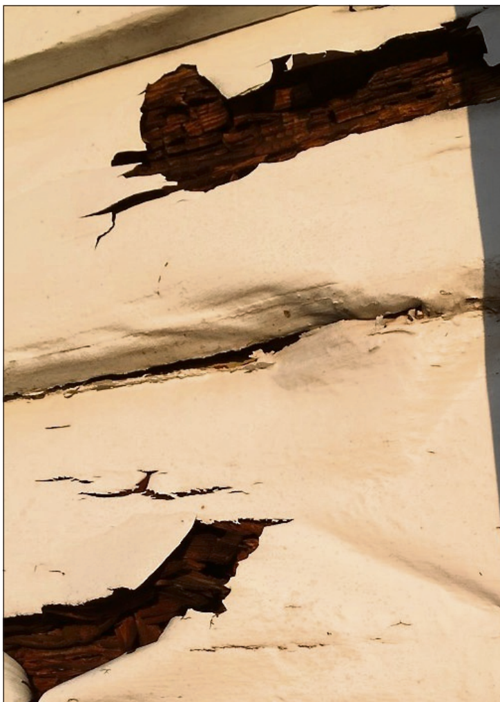
RÅTESKADEN: Veggen viste seg å være så omfattende at hele veggen måtte skiftes.
